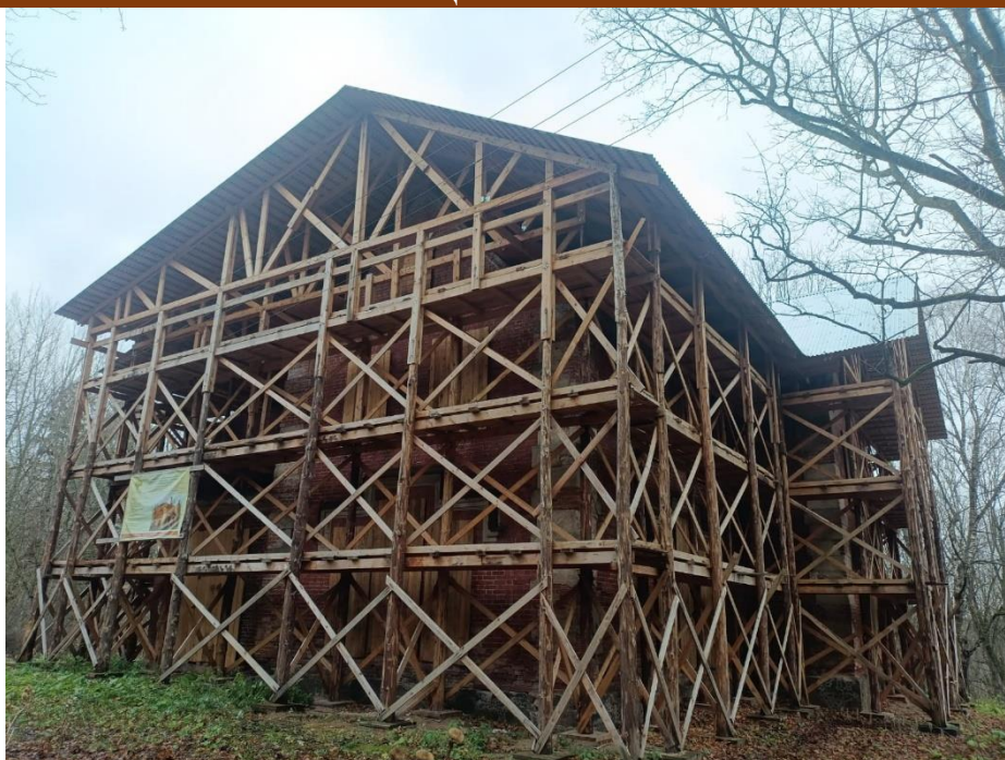
Реставрация усадьбы «Княжья Горка» (57.52806 с.ш. 29.91111 в.д.)
