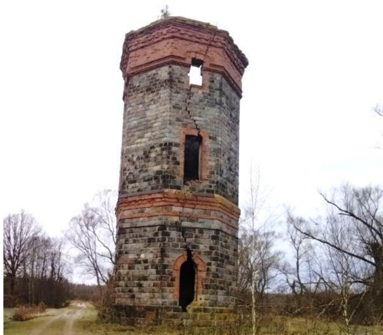
Вид на водонапорную башню станции Великополье (56.356691 с.ш. 30.821794 в.д.)
