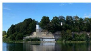
Фото 15. Снеготорский монастырь (южная башня), укрепления коренного берега (Мойский М., 2023)
